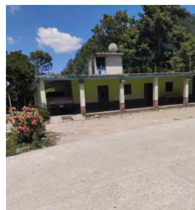
Vivienda del caserío Zapotalito
